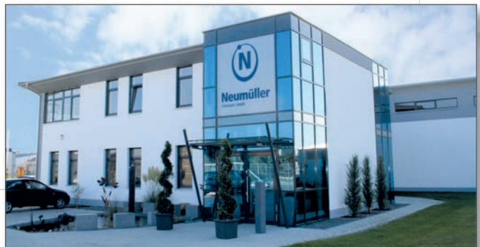
Zentrale in Weisendorf bei Nürnberg
